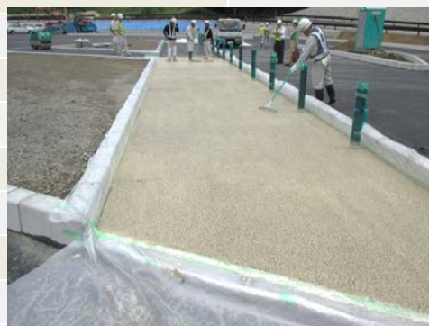
湖西道路・和邇IC (妹子の里駐車場での試験施工)
