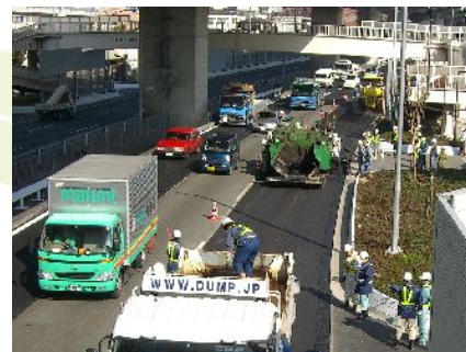
写真-1 再生骨材による試験舗装
