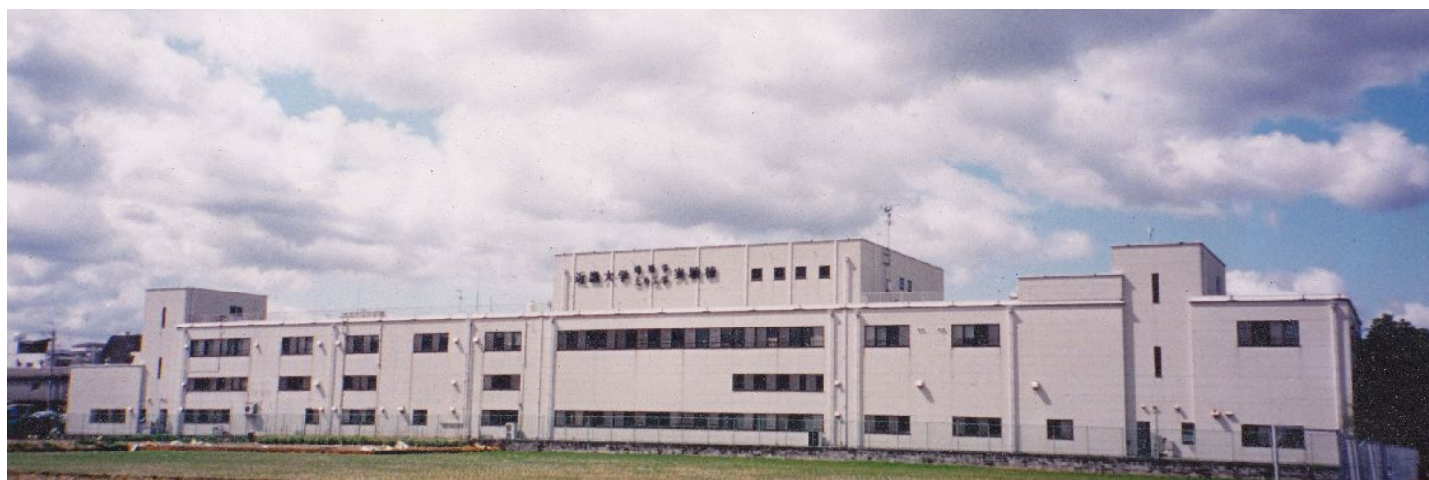
大阪中央環状線側からの実験棟（大阪府八尾市）
